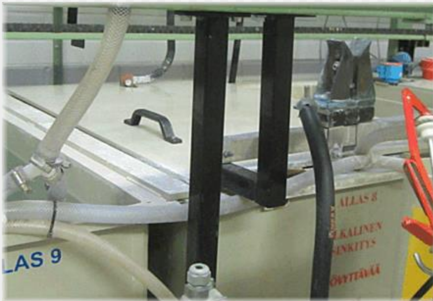
Kuva 7. Sinkityksen kansi paikallaan
