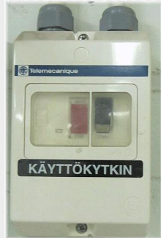
Kuva 2. Ilmanvaihdon kytkimet
