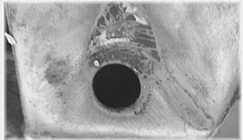
Kuva 3. Pinta ruosteenpoiston jälkeen.
