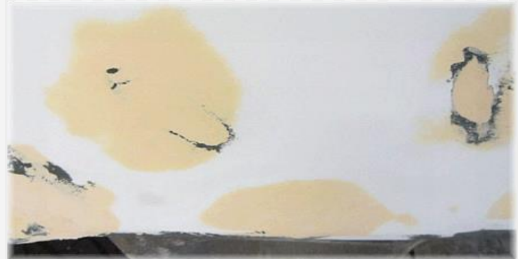
Kuva 6. Kittaus hionnan jälkeen
