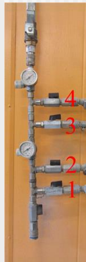
Kuva 6. Ilmaventtiilit sekoitukselle
